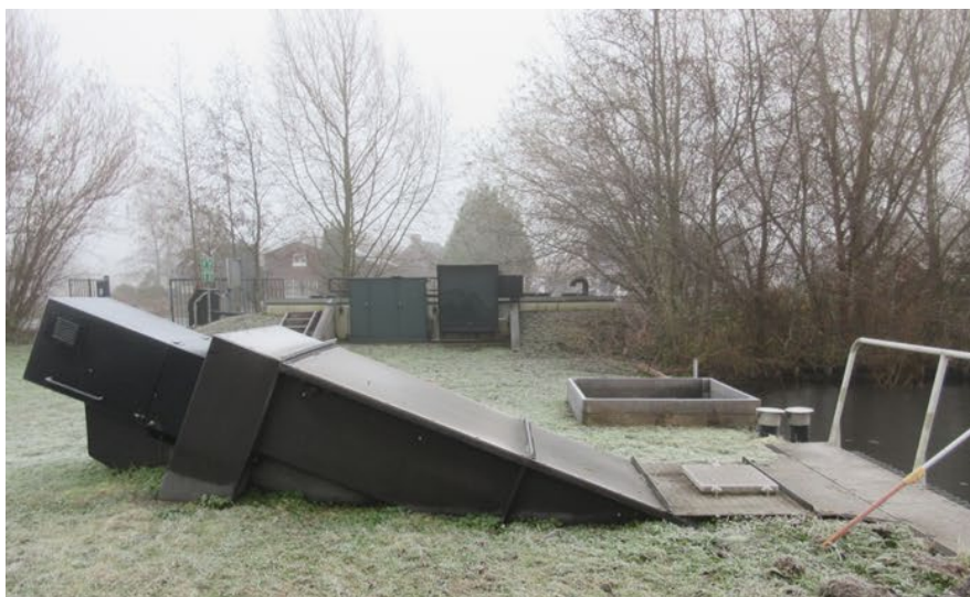
FIGUUR 3 Coagulatie (ijzerchloridedosering) bij de Nieuwkoopse Plassen (links) en de bijbehorende bezinksloot (rechts). Foto's afkomstig van B. Schaub, Rijnland.
