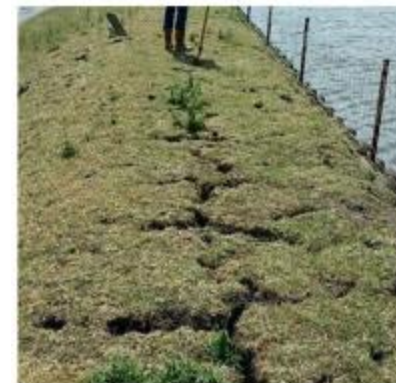
Figuur 5-12 Dijk in Delfland met droogtescheuren (Ponstee et al., z.d.)
