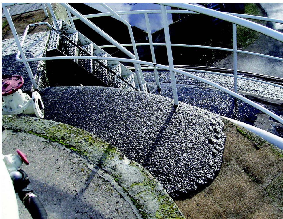
FIGUUR 1.1. ZICHTBAAR GEVOLG VAN SCHUIMVORMING IN DE SLIBGISTING VAN RWZI RAALTE IN 2005 (FOTO WATERSCHAP GROOT SALLAND)
