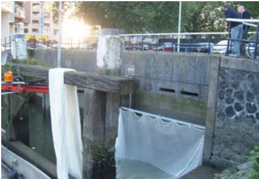
Fig 2.2 PLAATSING VAN HET PASSAGENET BIJ OPVOERWERK SCHILTHUIS
