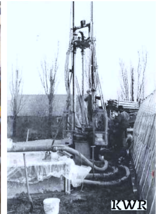
Aanleg ASR systeem bij glastuinbouwbedrijf te Bleiswijk in de periode 1970-1980 ( Zuurbier et al., 2012 )
