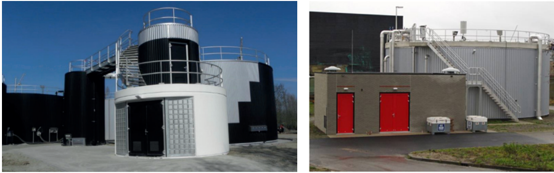
FIGUUR 46 DEMON® INSTALLATIES OP RWZI NIEUWEGEIN (LINKS, BRON: STOWA 2018-70) EN OP RWZI AMERSFOORT (RECHTS, BRON: BUUNEN-VAN BERGEN ET AL., 2014) 67
