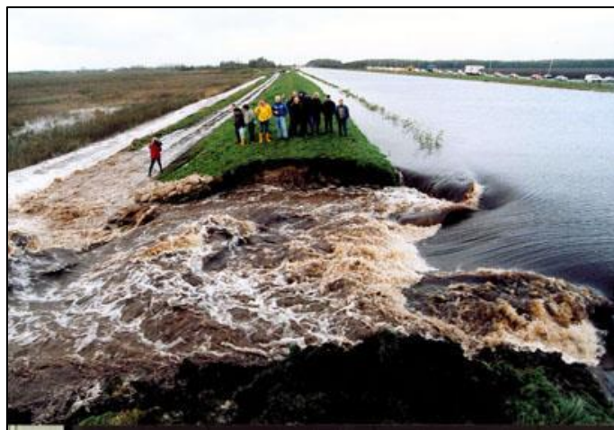
Figuur 17: Falen van een waterkering
