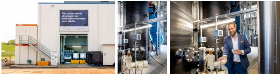
FIGUUR 3 PHA2USE-INSTALLATIE OP HET TERREIN VAN HVC IN DORDRECHT
