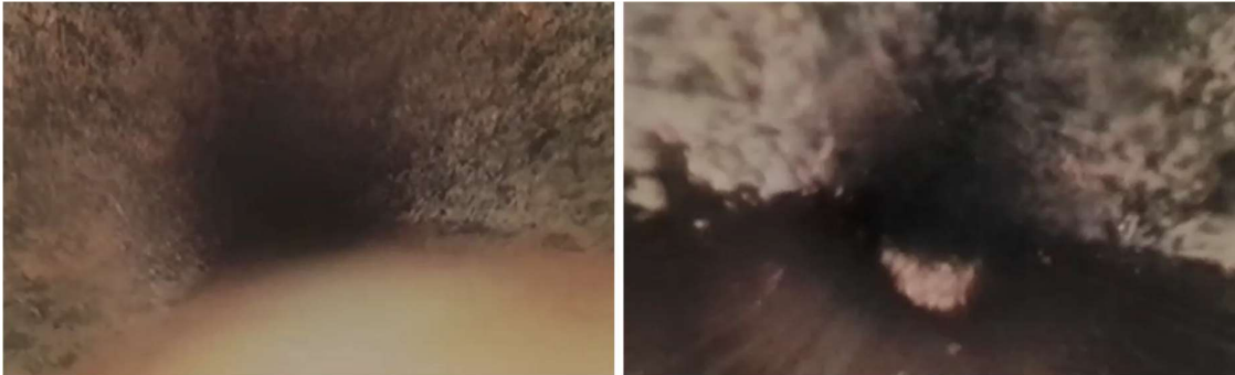
Figuur B3.11 Paar meter verder. Op rechterfoto zijn losse stukjes afzettingen zichtbaar
