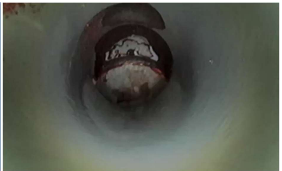
Figuur B5.17 In de 'pocket'. Camera onder water. 'Pocket' zo goed als helemaal schoon met op één plek nog een brok afzettingen zichtbaar
