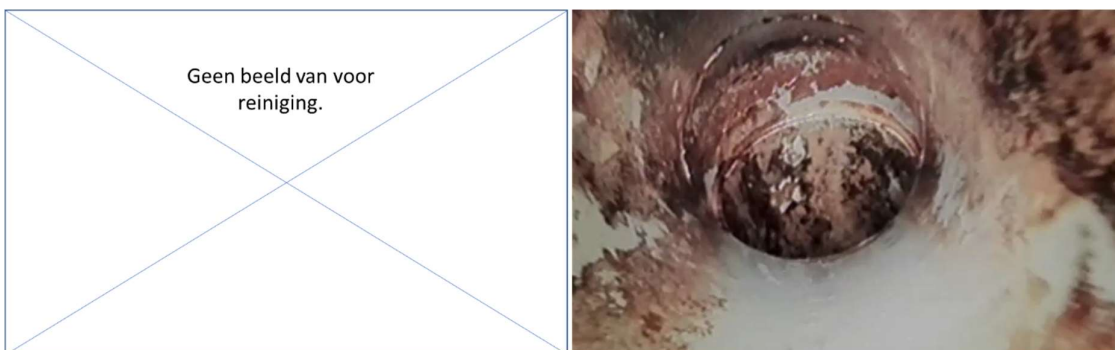
Figuur B4.9 Net voor neerwaartse bocht ('pocket'). Dikke afzettingen zijn verdwenen
