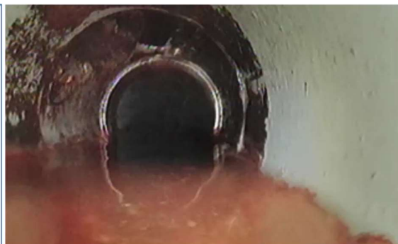
Figuur B4.15 Circa 2 meter verder. Schone leiding zichtbaar met op bodem nog wat afzettingen
