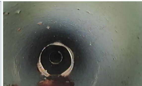
Figuur B4.12 In de doorgaande leiding net na inspectiepunt. De twee zichtbare 'ringen' betreft een stuk leidingdeel die in de voorbereiding is vervangen vanwege aanwezig gat die provisorisch was gedicht met ducttape
