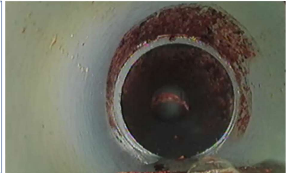
Figuur B5.16 Overgangsstuk met zichtbaar een neerwaartse bocht naar een 'pocket'
