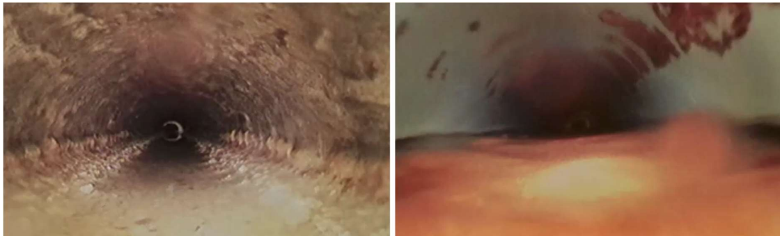
Figuur B5.10 Circa 1,5 meter verder. Op linkerfoto dikke laag afzettingen op bodem zichtbaar. In de verte is een overgangsstuk zichtbaar
