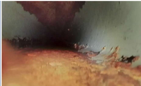
Figuur B4.17 Circa 4 meter verder. Schone leiding zichtbaar met op bodem nog wat afzettingen
