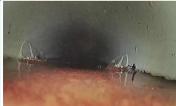
Figuur B4.16 Circa 3 meter verder. Schone leiding zichtbaar met op bodem nog wat afzettingen
