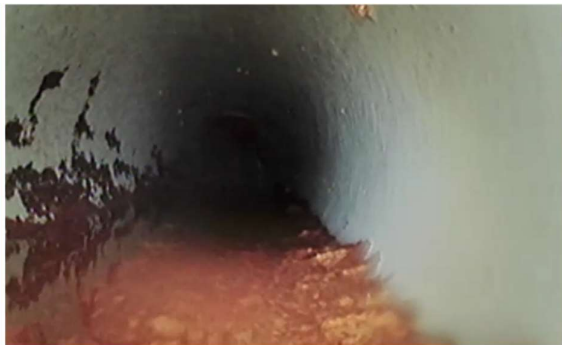
Figuur B4.14 Circa 1 meter verder. Schone leiding zichtbaar met op bodem nog wat afzettingen
