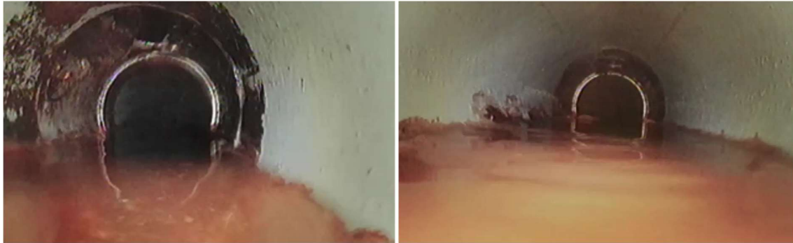
Figuur B4.25 Foto's circa 2 meter verder. Op de rechterfoto lijkt nog wat afzettingsmateriaal aanwezig. Leiding wel iets schoner dan op linkerfoto
