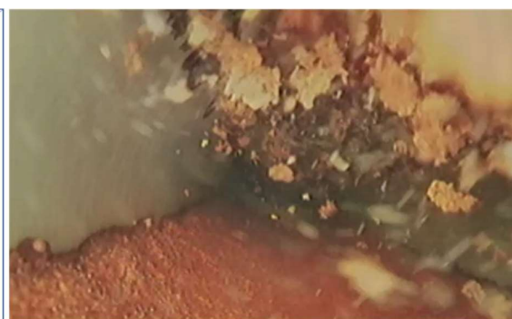
Figuur B5.14 Circa 1 meter verder. Camera onder water. Op de bodem is nog een laag aangekoekte afzettingen zichtbaar. De leiding is verder schoon
