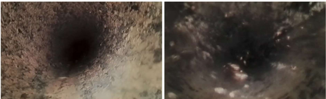
Figuur B3.10 Direct na bocht. Op rechterfoto zijn losse stukjes afzettingen zichtbaar
