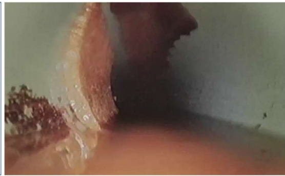
Figuur B4.25 Foto's circa 2 meter verder. Op de rechterfoto lijkt nog wat afzettingsmateriaal aanwezig. Leiding wel iets schoner dan op linkerfoto
