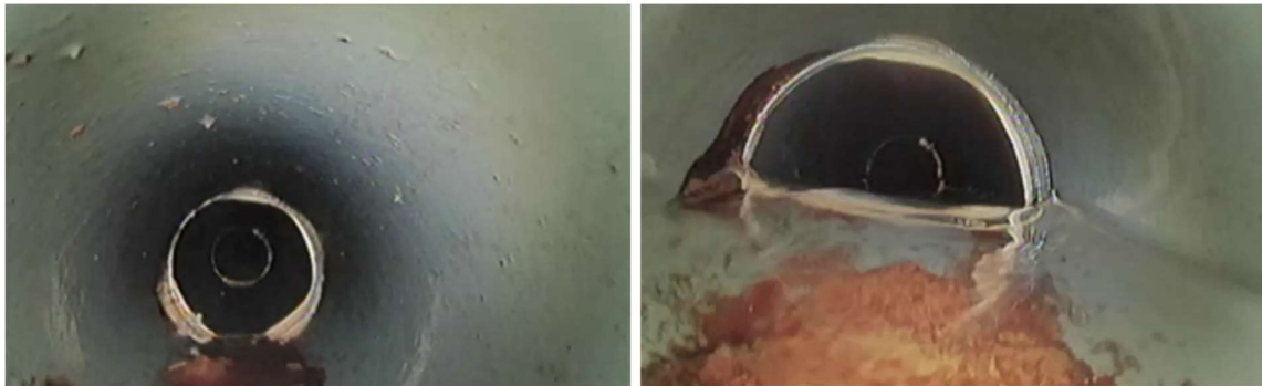
Figuur B4.22 Foto's net na inspectiepunt. Nog wat afzettingen op bodem zichtbaar, maar verder hele schone leiding
