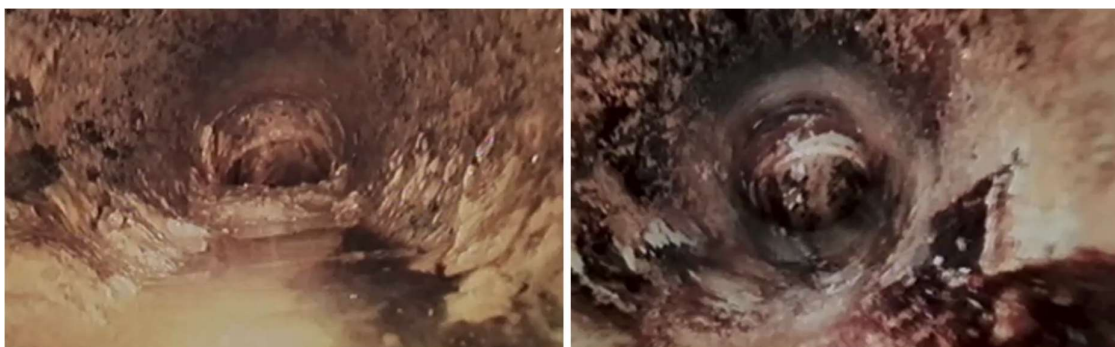
Figuur B4.8 Stukje verder net voor neerwaartse bocht ('pocket'). Op linkerfoto duidelijk dikke afzettingen zichtbaar
