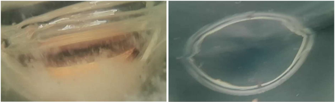
Figuur B5.1 Direct bij inspectiepunt, overgang van nieuw aangelegd inspectiepunt naar de bestaande leiding. Camera zit onder water. Op linkerfoto is een laag afzettingen op de bodem zichtbaar
