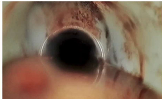
Figuur B5.8 Circa 0,5 meter verder. Links bovenin op de foto's komt inrikker binnen
