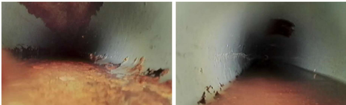
Figuur B4.27 Foto's circa 4 meter verder. Op de rechterfoto lijkt nog wat afzettingsmateriaal aanwezig. Leiding wel schoner dan op linkerfoto
