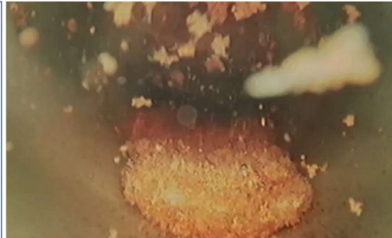
Figuur B5.7 Camera onder water. Laag afzettingen zichtbaar op bodem (zit aangekoekt)
