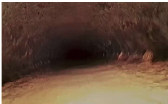
Figuur B5.9 Circa 1 meter verder. Op linkerfoto dikke laag afzettingen zichtbaar, ook dikker dan op voorgaande foto's. Op rechterfoto nog steeds een laag afzettingen op bodem zichtbaar. Leiding is verder wel schoon
