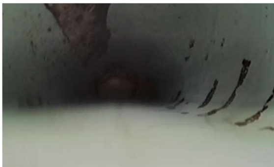
Figuur B5.19 Schone leiding vlakbij inspectiepunt
