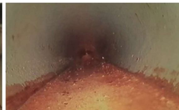
Figuur B5.21 Na de neerwaartse bocht. Op de rechterfoto is nog steeds een laag afzettingen op de bodem zichtbaar
