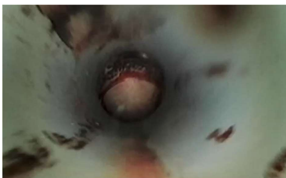
Figuur B5.20 Neerwaartse bocht. Leiding schoon. Het laagje op de bodem van de rechterfoto is gruis
