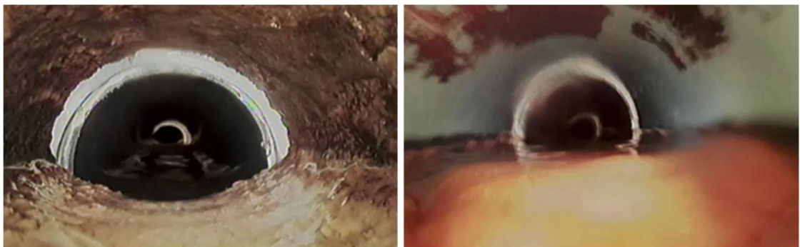
Figuur B5.11 Het overgangsstuk. De twee zichtbare 'ringen' betreft een stuk leidingdeel die in de voorbereiding is vervangen vanwege aanwezige gaten
