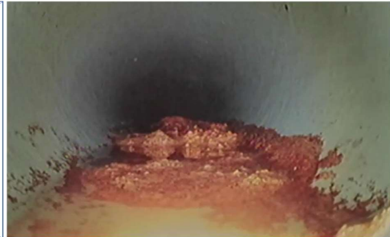
Figuur B4.13 In de neerwaartse bocht ('pocket'). Op linkerfoto duidelijk dikke afzettingen zichtbaar. Op rechterfoto zijn de dikke afzettingen verdwenen
