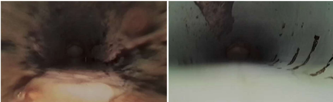
Figuur B5.2 Stukje verder met zichtbaar in de verte een neerwaartse bocht. Op linkerfoto is een dikke laag afzettingen zichtbaar op de bodem
