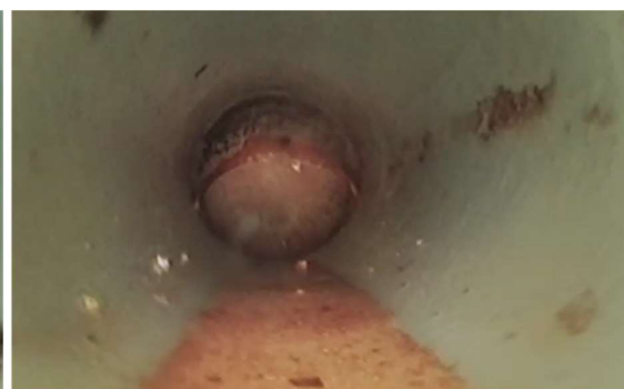
Figuur B5.20 Neerwaartse bocht. Leiding schoon. Het laagje op de bodem van de rechterfoto is gruis
