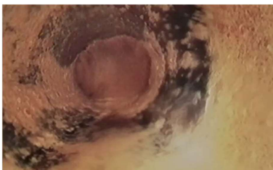
Figuur B4.34 Direct na bocht. Zichtbaar is bocht naar links waar deze leiding inpikt op de hoofdleiding. Van rechts komt de leiding van de linkervleugel van het zorgcomplex
