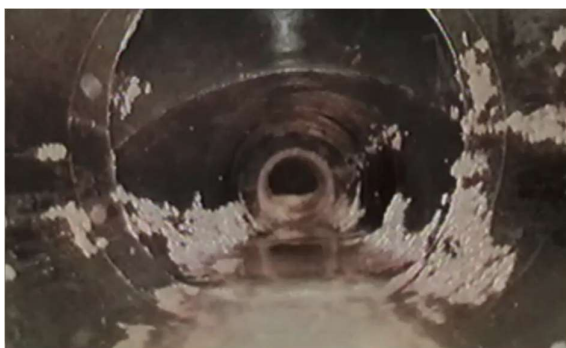
Figuur B4.1 Direct bij inspectiepunt met zichtbaar de overgang naar de in pandige riolering
