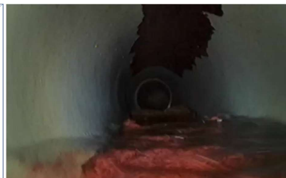
Figuur B5.15 Circa 2 meter verder. Op de bodem is nog een laag aangekoekte afzettingen zichtbaar. De leiding is verder schoon. In verte een overgangsstuk zichtbaar
