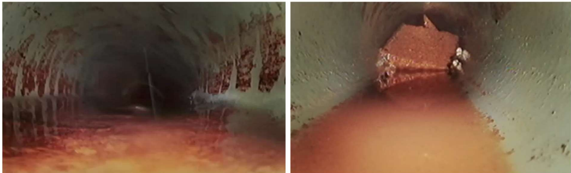
Figuur B5.22 Op linkerfoto is een laag afzettingen op de bodem zichtbaar. Op de rechterfoto zijn geen afzettingen mee op de bodem meer aanwezig. Wel zijn losse stukjes afzettingen zichtbaar die zijn losgekomen als gevolg van de hogedruk spuit. Na deze opname is er geen goed beeld meer, omdat de camera de stukjes voor zich uit drukte. Vanwege risico op verstoppingen is besloten om niet verder te gaan
