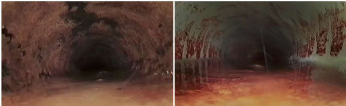
Figuur B5.5 Stukje verder. Op beide foto's nog steeds laag afzettingen op bodem zichtbaar
