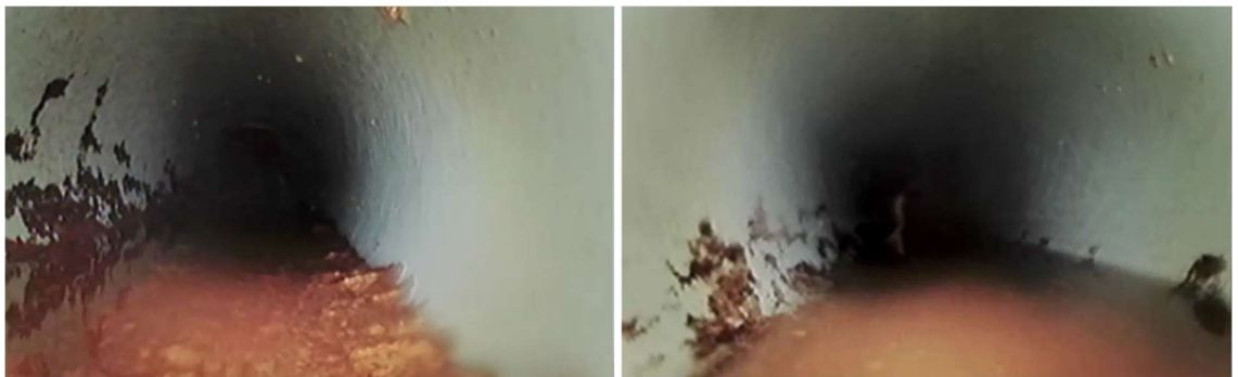
Figuur B4.24 Foto's circa 1 meter verder. Op de rechterfoto lijkt nog wat afzettingsmateriaal aanwezig. De dikkere stukken zoals zichtbaar op linkerfoto zijn verdwenen
