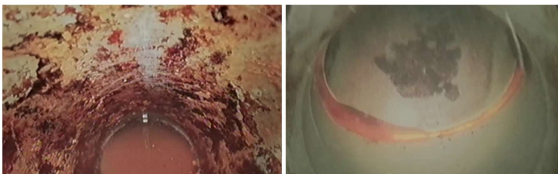
Figuur B4.20 Rechterfoto in de 'pocket' net na neerwaartse bocht. Leiding is schoon
