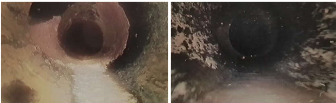
Figuur B3.13 Paar meter verder. Links op de foto's is een inprikker zichtbaar. Dit de hoofdleiding van de andere vleugel van het zorgcomplex. Voor verder beeldmateriaal van de leiding richting het vacuümstation zie bijlage 4b
