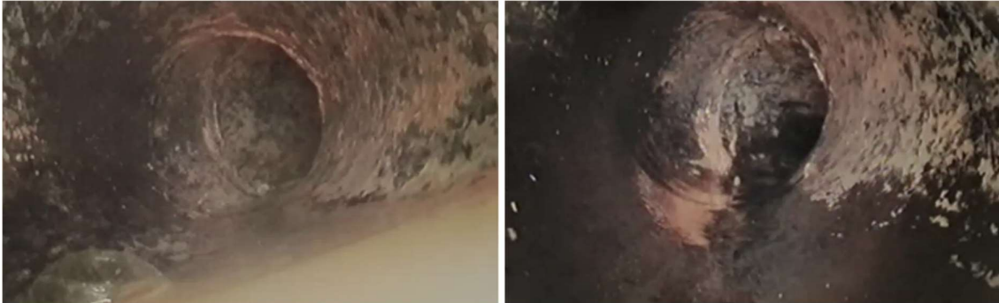
Figuur B3.1 Leiding bij inspectiepunt met zichtbaar een bocht naar rechts
