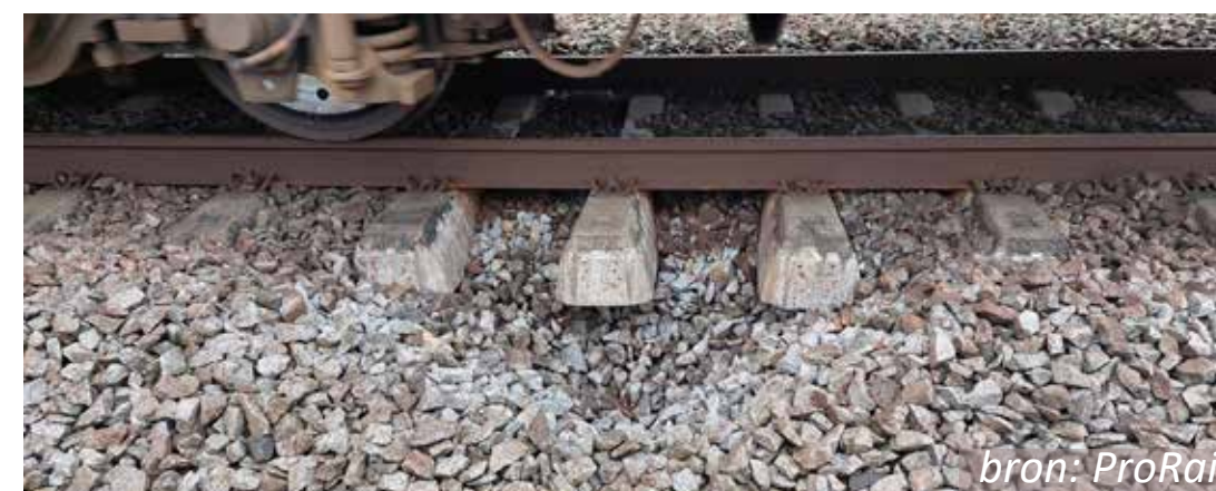
verzakking door beverhol onder spoor
