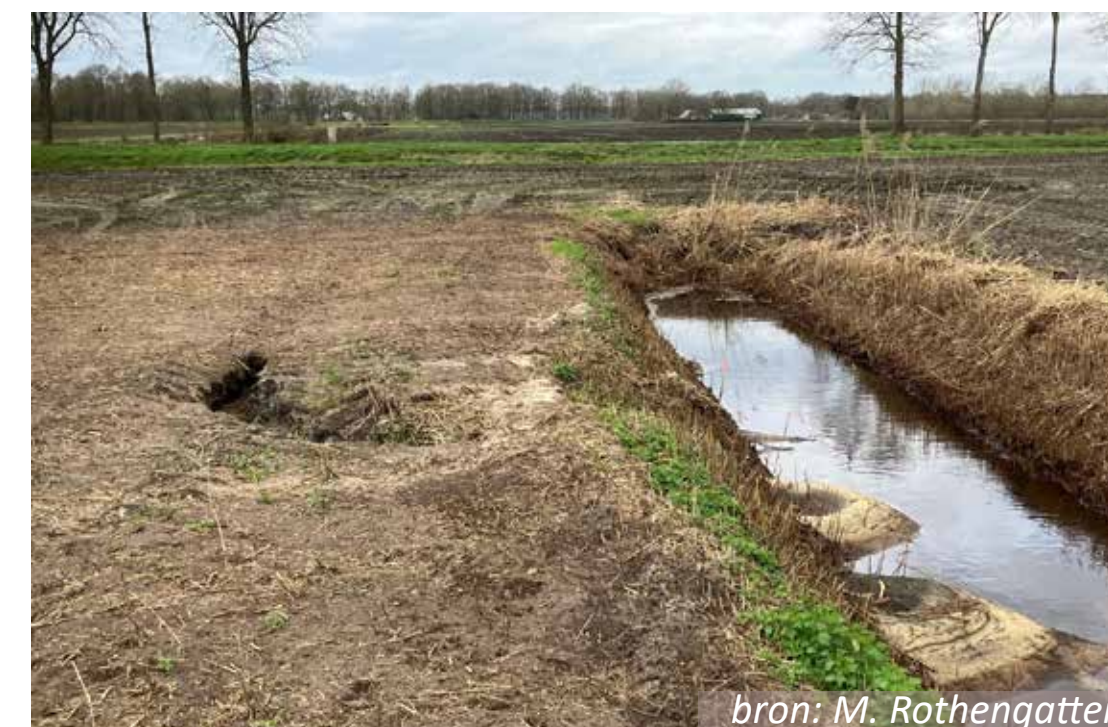
schade door ingezakte holen
