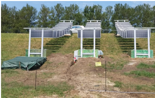
FIGUUR 4.2 OVERZICHT VAN DE PILOTS MET VERTICALE PV-SYSTEMEN VAN SOLTRONERGY (LINKS) (VAN DER SCHOOT EN VAN DER VOORT, 2022) EN OP DE DRIELSEDIJK (RECHTS) (DE KONING, 2023)
