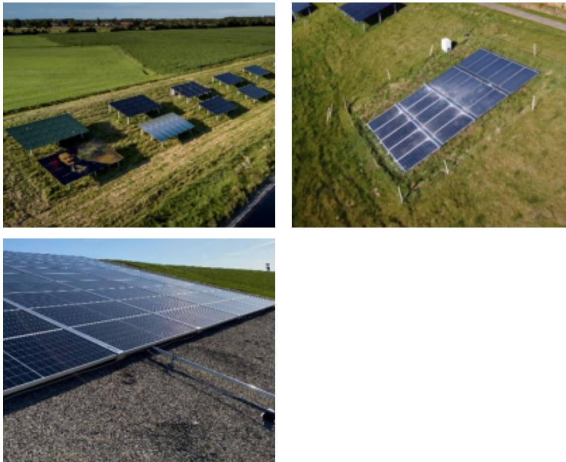
FIGUUR 4.1 OVERZICHT VAN DE DRIE GETESTE HORIZONTALE PV-SYSTEMEN: EURORAIL (LINKS), DELMECO (RECHTS) AFVALZORG (ONDER) (CONSORTIUM ZON OP DIJKEN, 2023)
